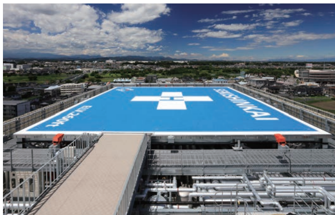
▲病院屋上ヘリポート
